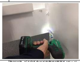
取付け後、ビス穴を合せて内側の2箇所を M8×15mm ナベ六角ビスで固定します。
