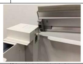
最後に配線カバーを付けます。カバー受けのツメにカバー裏面の切り欠きを合わせて、上から被せるようにして付けます。
