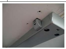
天板前後の位置、段差、目地の隙間に注意して取り付けてください。横連結終了後、全てのビスを本締めします。
